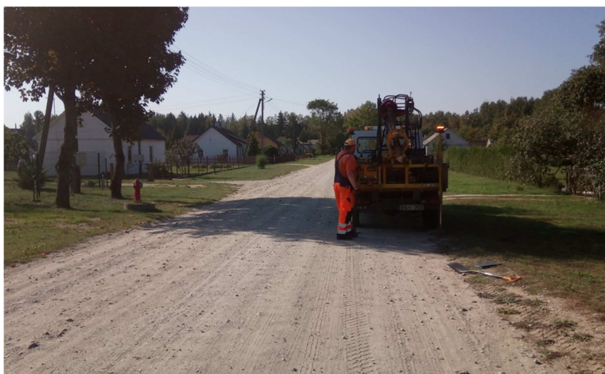
1 pav. Lauko darbai
